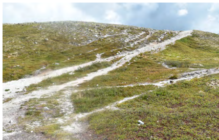
STOR – Bratt skråning med ustabil substrat
